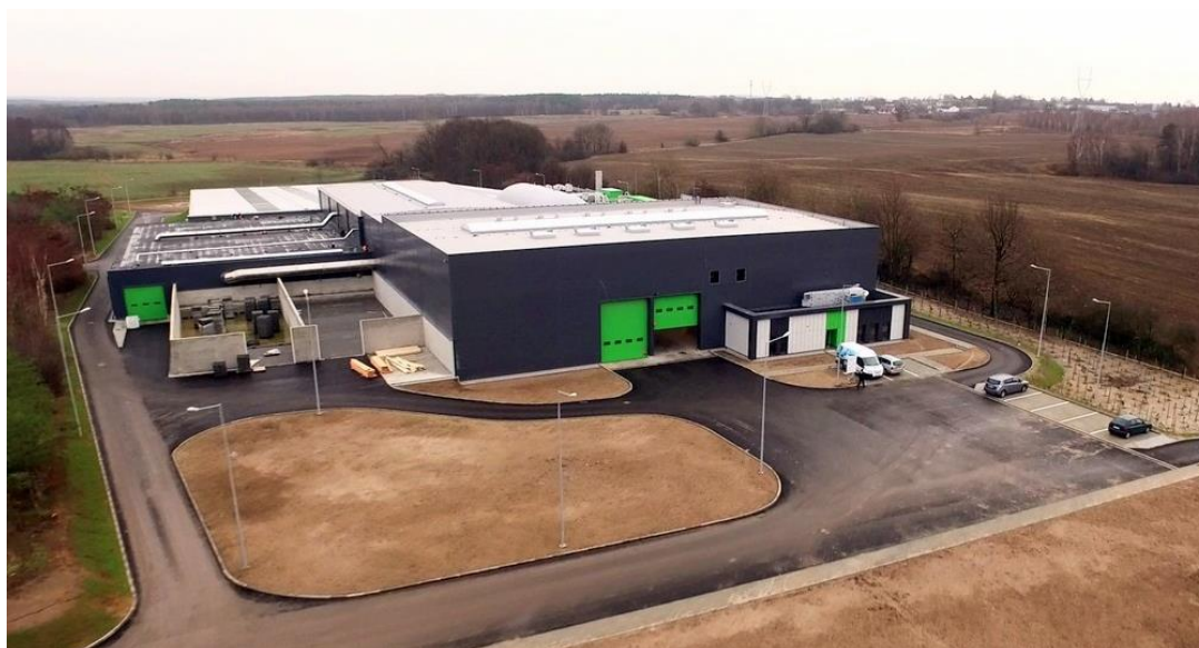
Rysunek 5. Instalacja do odzysku odpadów biodegradowalnych – Biokompostownia
