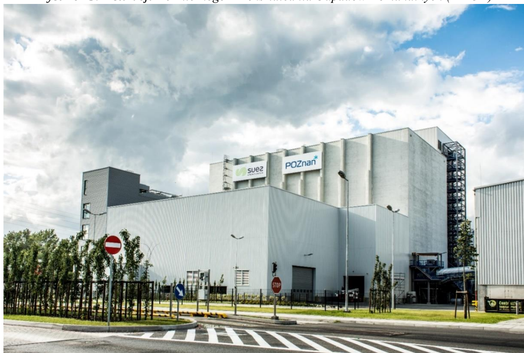
Rysunek 3. Instalacja Termicznego Przekształcania Odpadów Komunalnych (ITPOK)
