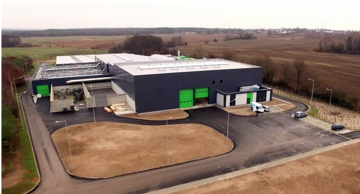
Rysunek 5. Instalacja do odzysku odpadów biodegradowalnych – biokompostownia - Poznań
