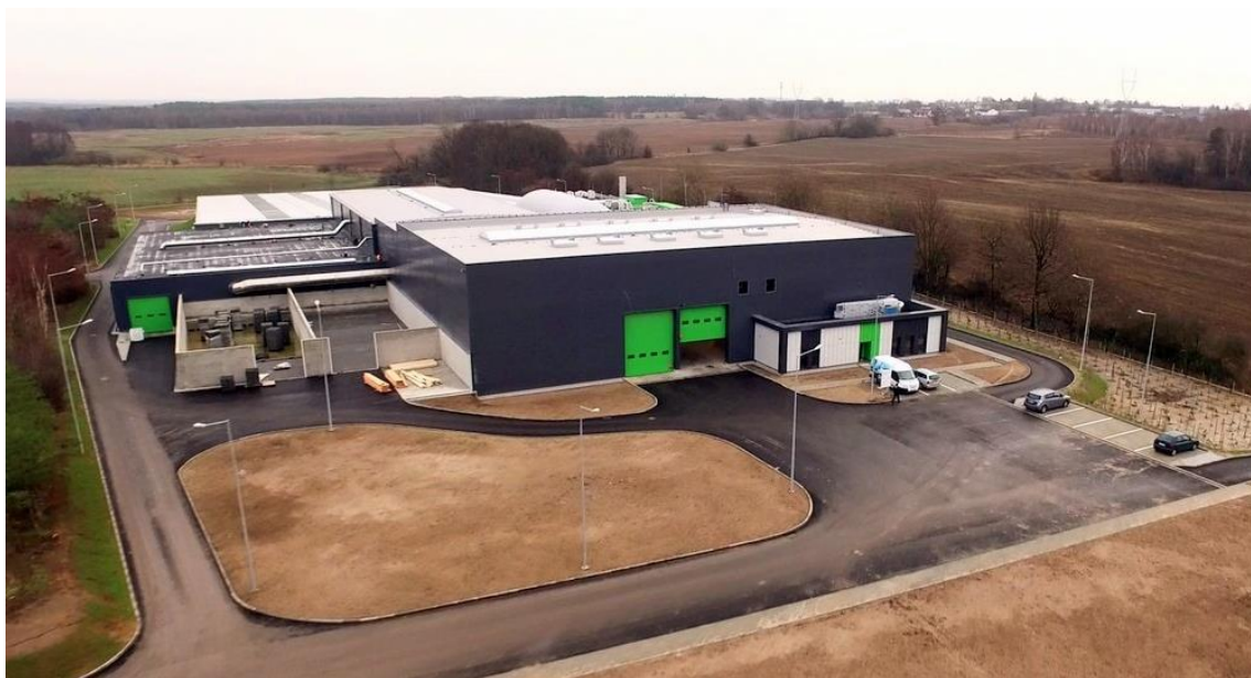
Rysunek 5. Instalacja do odzysku odpadów biodegradowalnych – Biokompostownia
