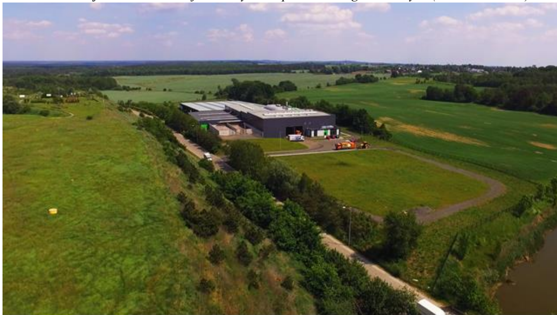
Rysunek 6. Instalacja do odzysku odpadów biodegradowalnych (czerwiec 2017 r.)
