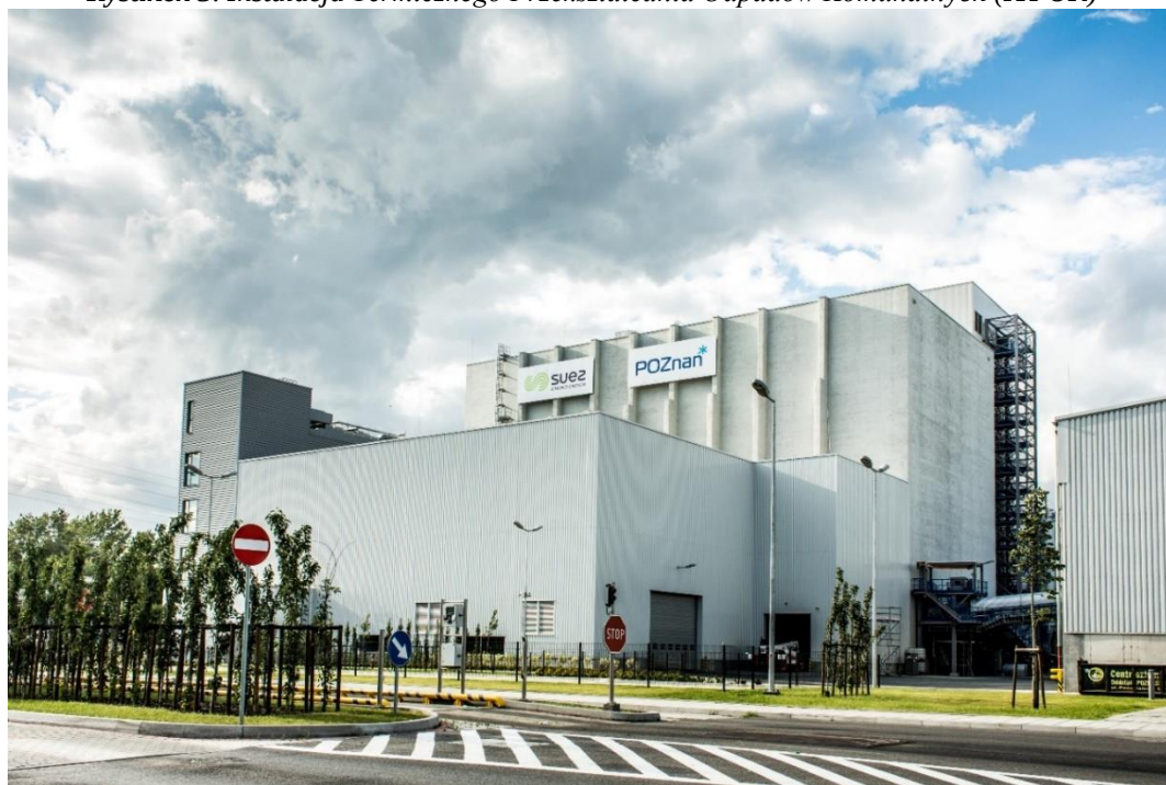
Rysunek 3. Instalacja Termicznego Przekształcania Odpadów Komunalnych (ITPOK)
