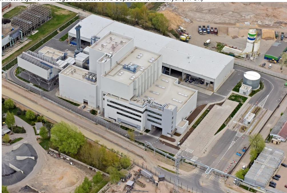
Rysunek 4. Instalacja Termicznego Przekształcania Odpadów Komunalnych (ITPOK)
