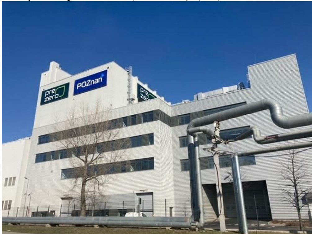
Rysunek 3. Instalacja Termicznego Przekształcania Odpadów Komunalnych (ITPOK)
