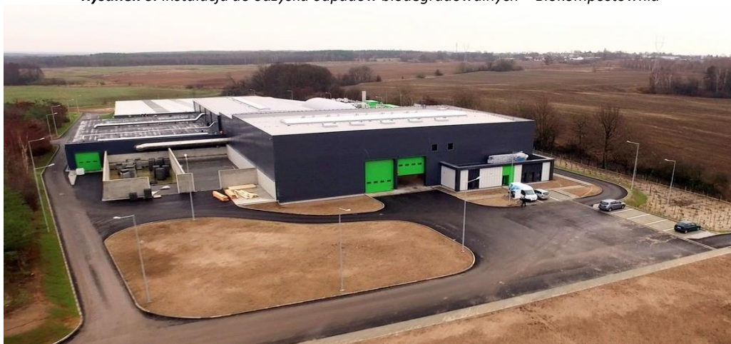
Rysunek 6. Instalacja do odzysku odpadów biodegradowalnych – Biokompostownia
