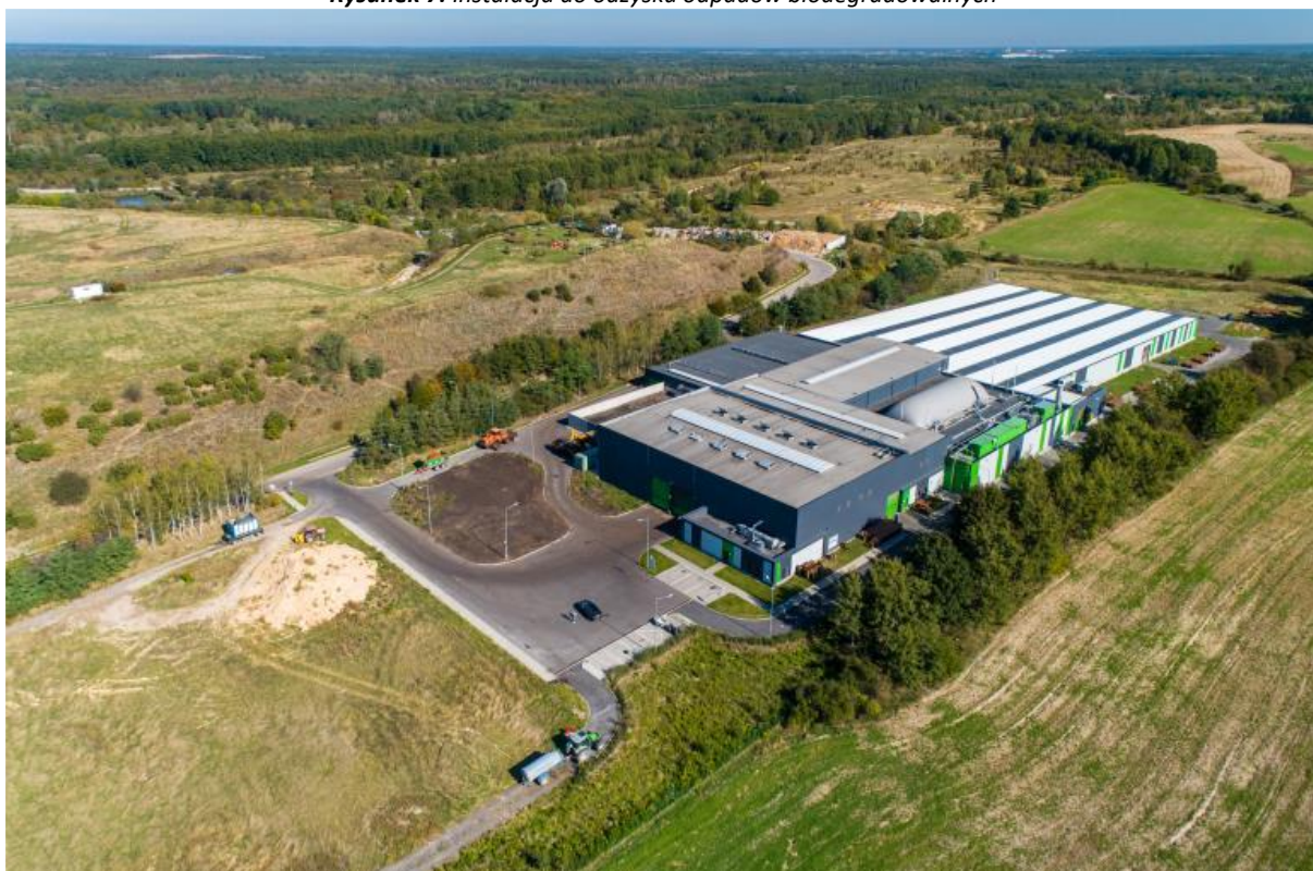
Rysunek 7. Instalacja do odzysku odpadów biodegradowalnych
