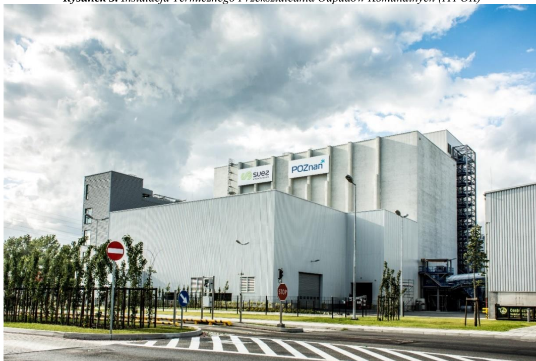
Rysunek 3. Instalacja Termicznego Przekształcania Odpadów Komunalnych (ITPOK)
