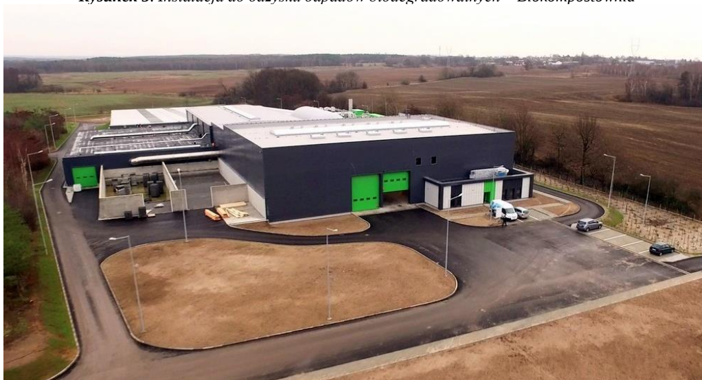
Rysunek 5. Instalacja do odzysku odpadów biodegradowalnych – Biokompostownia
