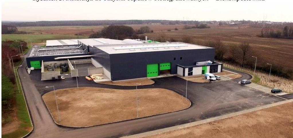
Rysunek 5. Instalacja do odzysku odpadów biodegradowalnych – Biokompostownia
