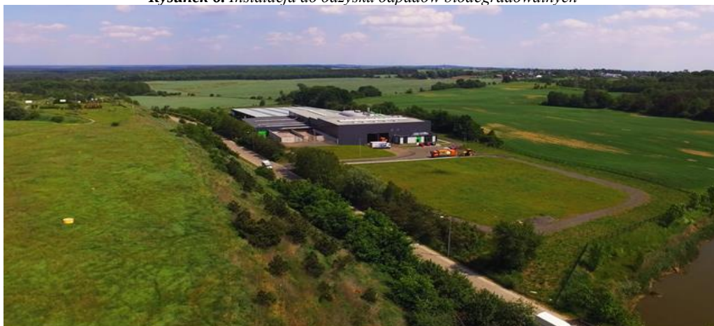
Rysunek 6. Instalacja do odzysku odpadów biodegradowalnych
