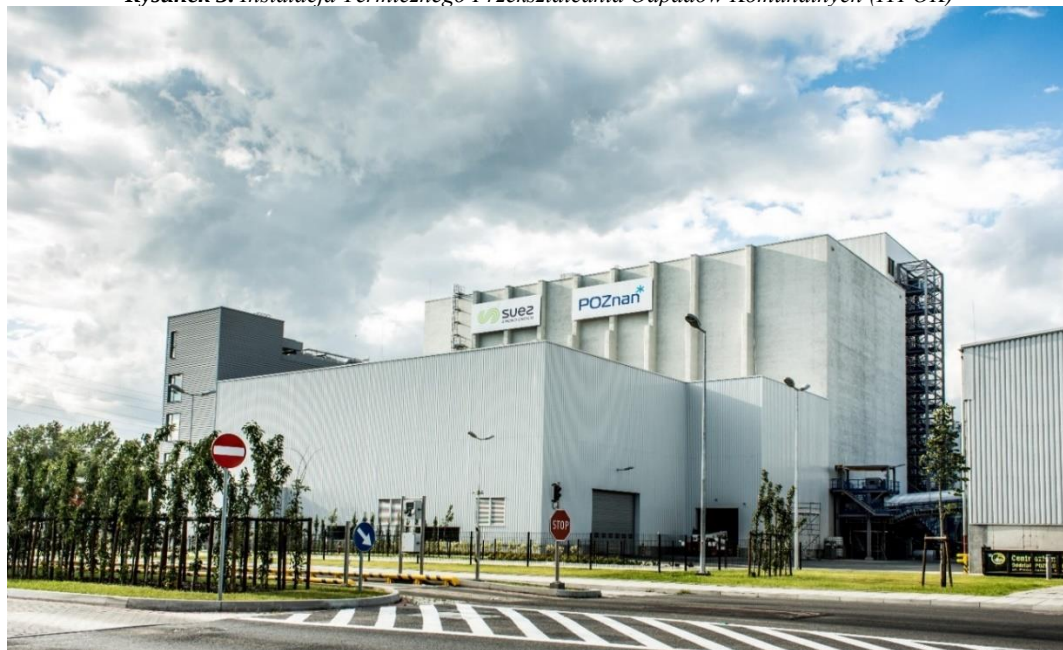
Rysunek 3. Instalacja Termicznego Przekształcania Odpadów Komunalnych (ITPOK)
