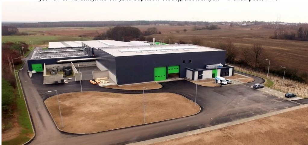
Rysunek 6. Instalacja do odzysku odpadów biodegradowalnych – Biokompostownia
