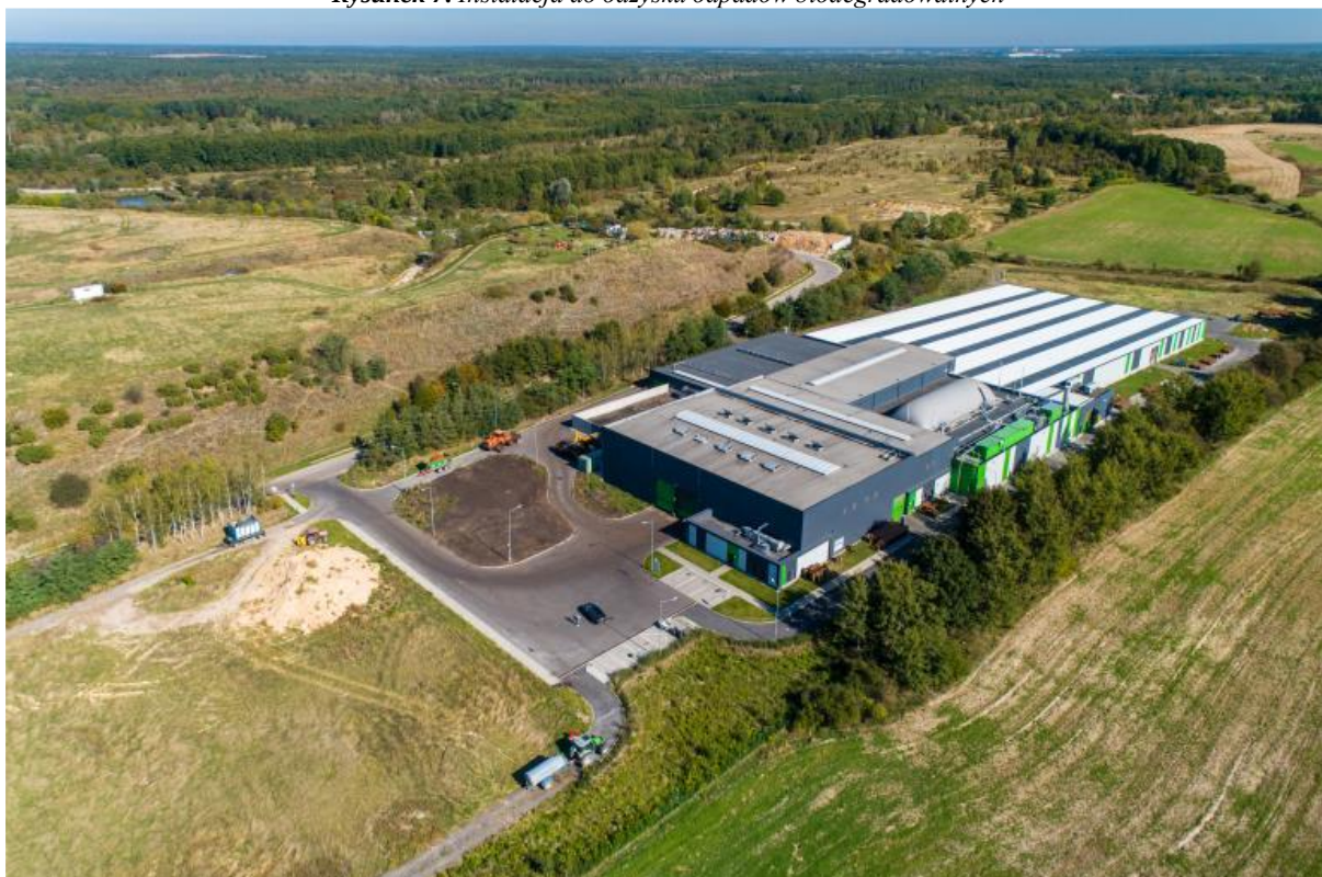
Rysunek 7. Instalacja do odzysku odpadów biodegradowalnych
