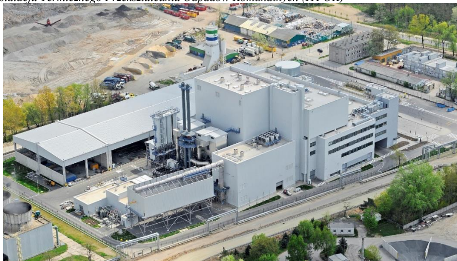
Rysunek 4. Instalacja Termicznego Przekształcania Odpadów Komunalnych (ITPOK)
