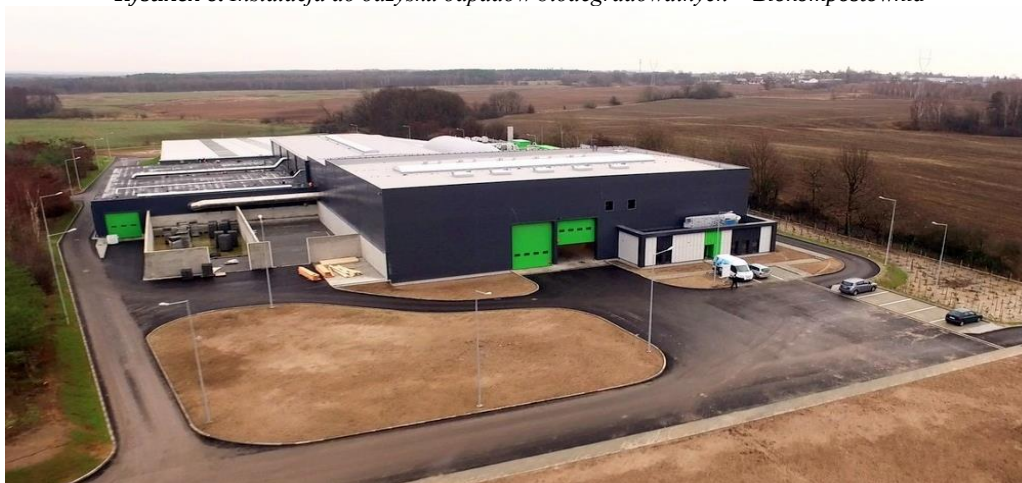
Rysunek 6. Instalacja do odzysku odpadów biodegradowalnych – Biokompostownia
