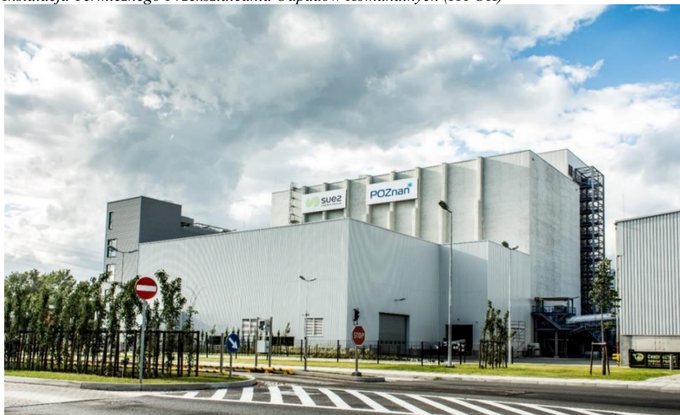
Rysunek 3. Instalacja Termicznego Przekształcania Odpadów Komunalnych (ITPOK)
